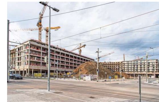
Die Baustelle vor wenigen Monaten KLZ/JÜRGEN FUCHS
