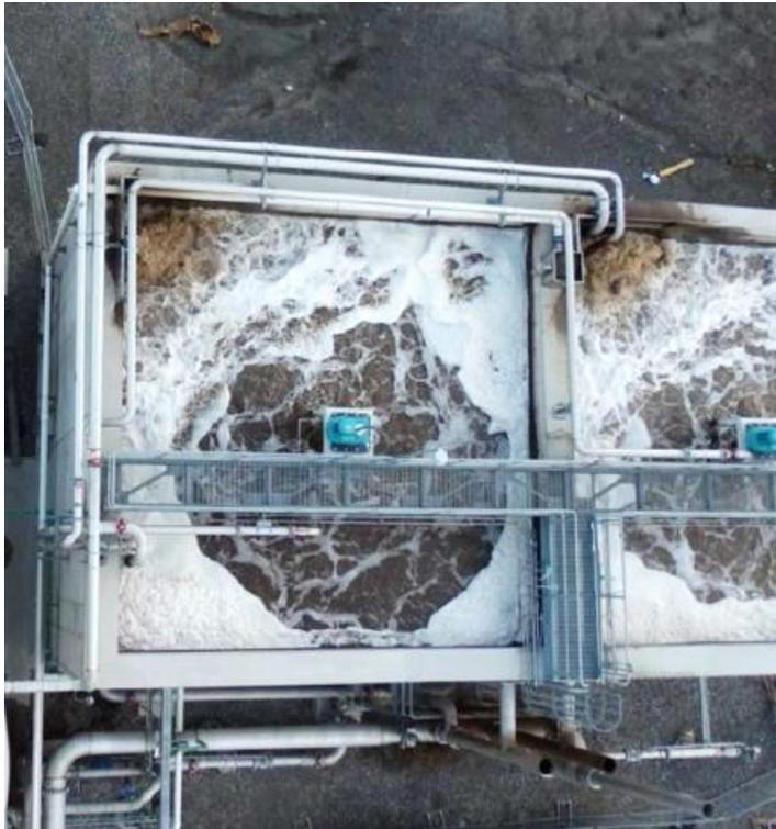
Abbildung 24: Flash Aeration der UASB Anlage um geruchsintensive Stoffe wie Schwefel-Verbindungen zu oxidieren (Foto: MERI)
