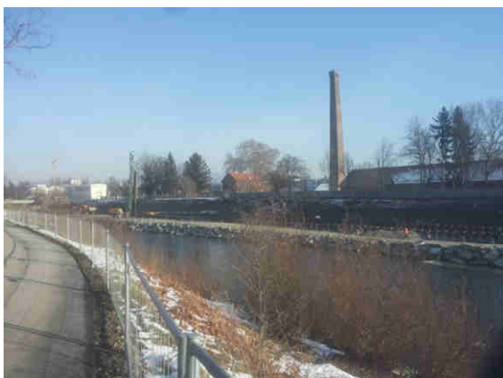
Abbildung 4: Radweg am Murufer, mit Blick auf das Veranstaltungszentrum Seifenfabrik. Das Murufer wird durch die Bauarbeiten für den Zentralen Speicherkanal und das neue Murkraftwerk neu gestaltet. Bildquelle: AEE INTEC
